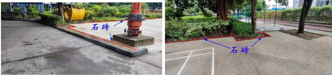
(2) 两棵树方框内侧砌砖、贴小条砖、铺麻石、框内回填沙土地
