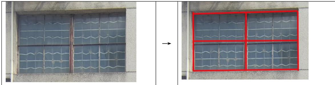
编号 9、10、15、16 窗 (4 个, 在教师休息室和接待室内), 拆除窗框、玻璃和防盗金属栅栏, 安装趟窗。具体如下图所示。
